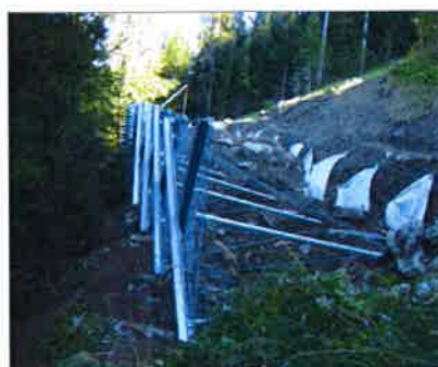
VELA SV: Die Module haben eine Höhe bis 3,5 m und können auch in Reihen übereinander angeordnet werden. Die Verankerung erfolgt je nach Gelände mittels Bodenplatte oder Felsanker.
